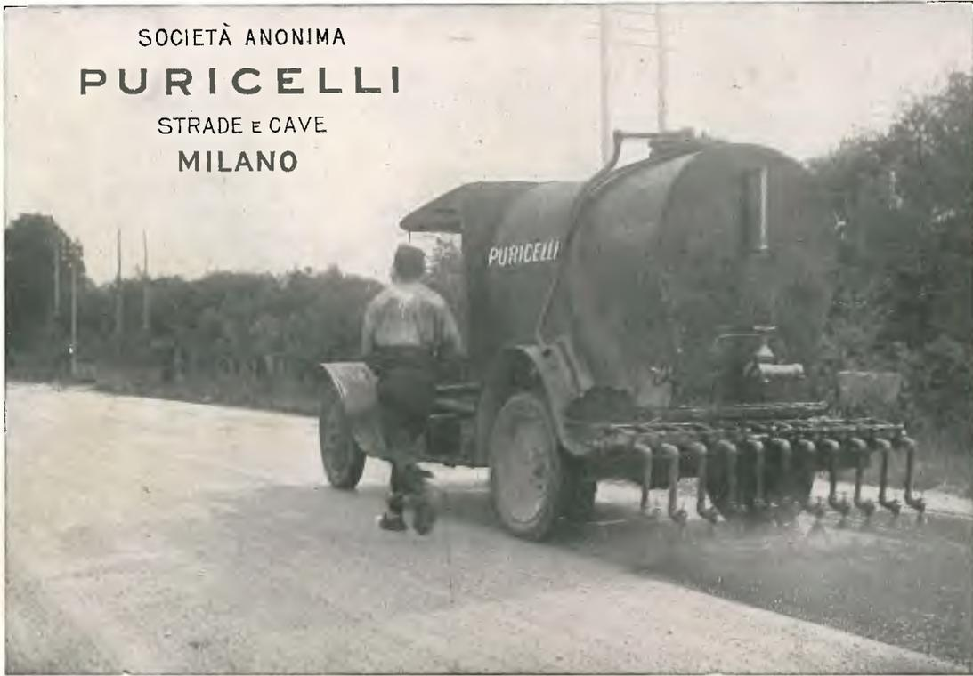
Applicazione bitumoid Puricelli mediante spanditrice automobile
